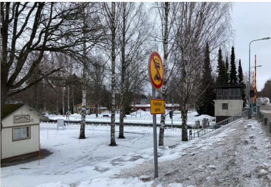
Kuva 4 odotushuone takaviistosta sululle päin. Konttien sijoituspaikkaa rajaa Kanavatien jyrkkä pengeri.
